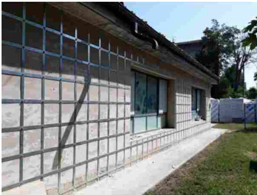
Scuola dell'infanzia oggetto dell'intervento (Credits: Progetto Sisma)
