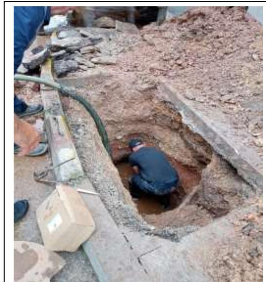
Slika 9. Opravke kvarova na glavnim vodovodnim cjevima u ulici Ibrahima Ljubovića. (07.11.2022.g.)
