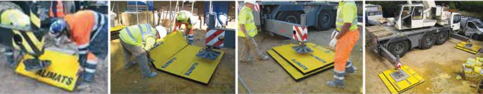
FOR USE UNDER MOBILE/SELF ERECT CRANES •
