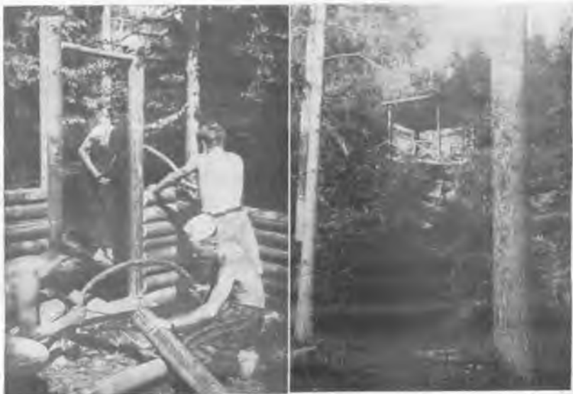
Stavba srubu 49. OS r. 1932.
