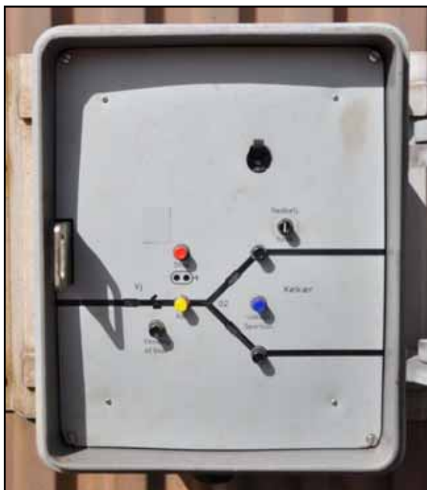
Sportavle (nødpanel) type DSB 1977, åbent
