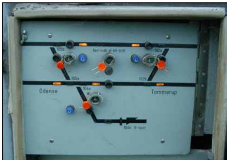
Sportavle, dobbeltspor, med mulighed for indkobling af AG-drift
