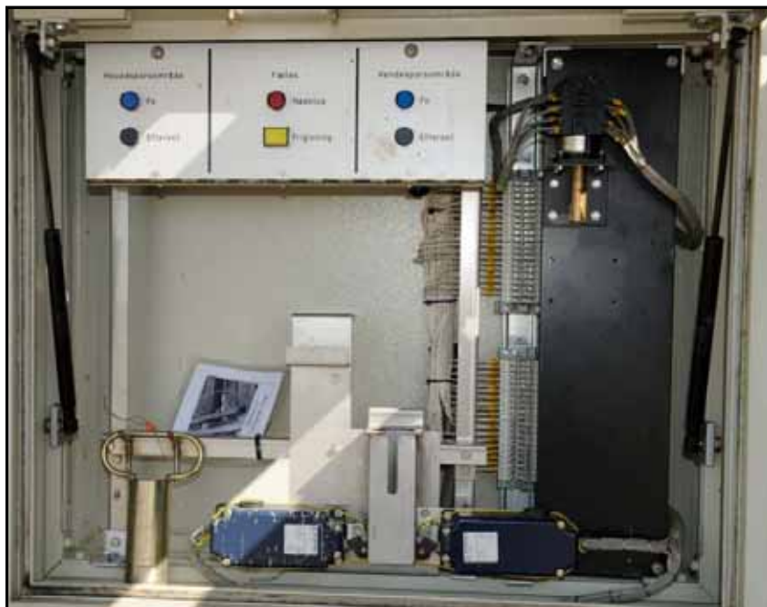
Skab med nødpanel type DSB 1990
