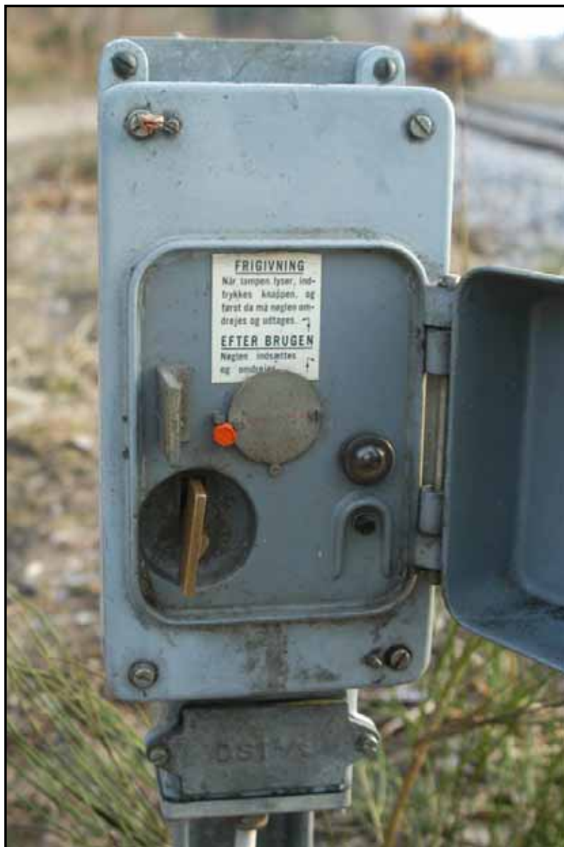
Skab med hovednøgle til elektromagnetisk nøglelåst sporskifte
