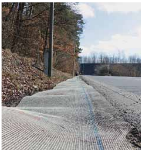
Stavba ochranného oplátku u frekventované silnice Building of fencing at a busy road
