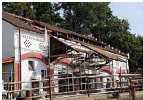
Výstavba hřiště na půdě statku Building of a new playground in the farm loft
