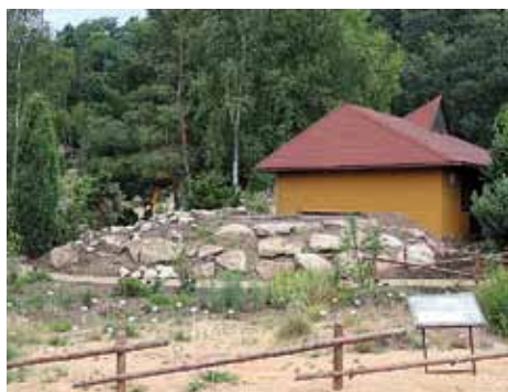
Nové výsadby u vodárny New planting at the water tower
