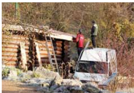
Oprava expozice Sibiřský les A repair of the Siberian Hut exhibit
