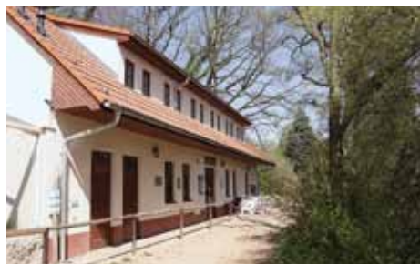
Svět v podzemí The Underground World
