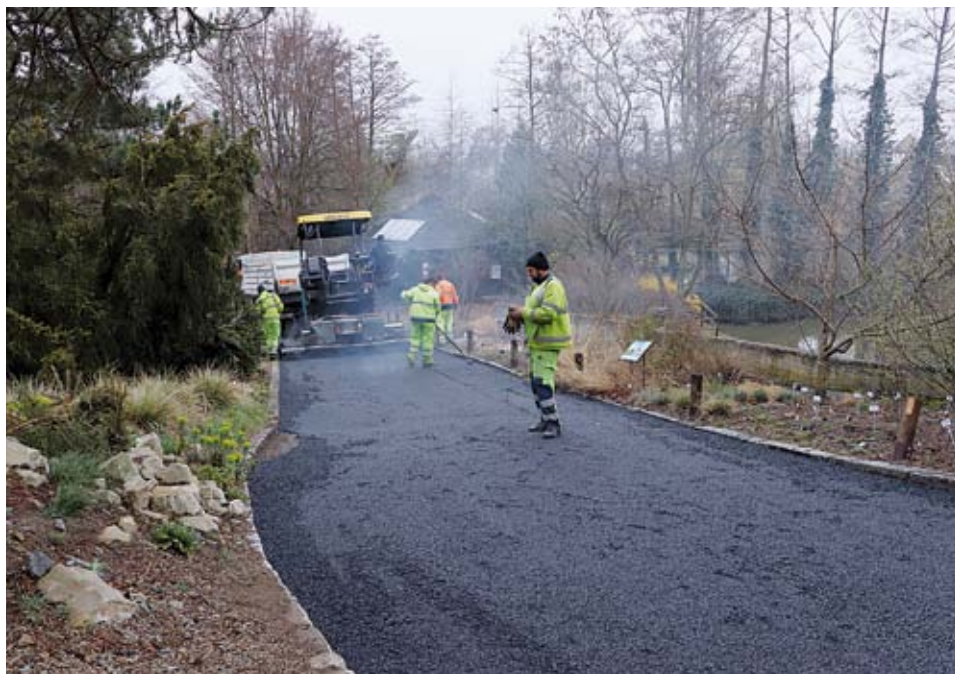
Asfaltování návštěvnické cesty u voliery pohoří Atlas. KM Asphalting the path at the Atlas Mountain range exhibit
