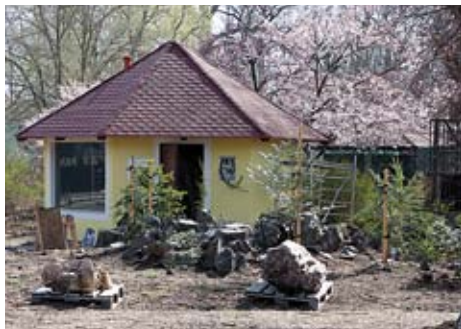
Domek plameňáků po opravě v roce 2021. KM The house of flamingos after repair in 2021
