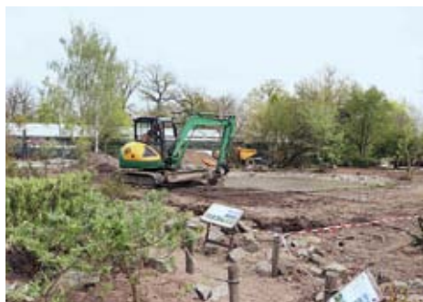
Počátek budování voliéry, 19. 5. 2022. KM The start of aviary erection, 19th May 2022
