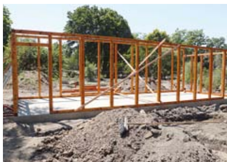
Budování pozorovatelny plameňáků, 3. 6. 2022. KM Building of the birds' observatory, 3rd June 2022
