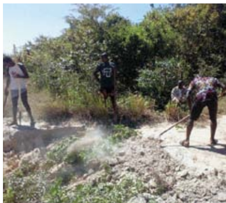
Údržba příjezdové silnice do národního parku Sahamalaza
