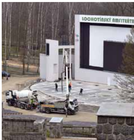
Technika při opravě pódia amfiteátru Repair of the amphitheatre stage
