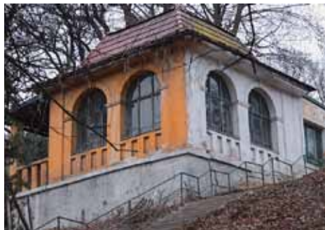
Původní altán The original summerhouse
