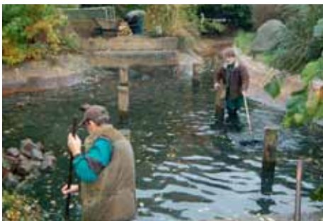
Oprava lávky mezi ostrovem lemurů a africkým nočním pavilonem Repair work on a footbridge between lemurs and African Night Pavilion
