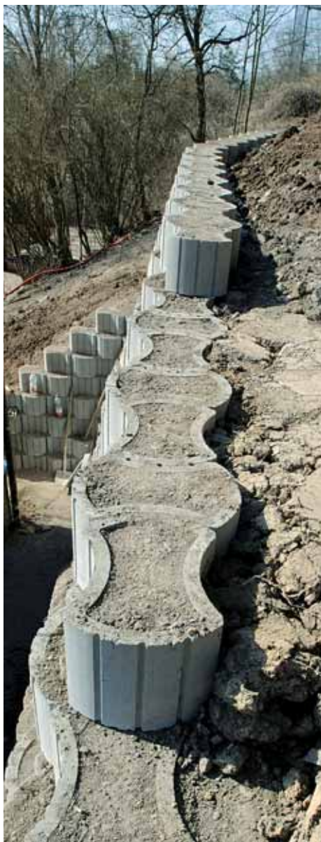
Opěrná zeď nad skleníkem The supportive wall above the green house
