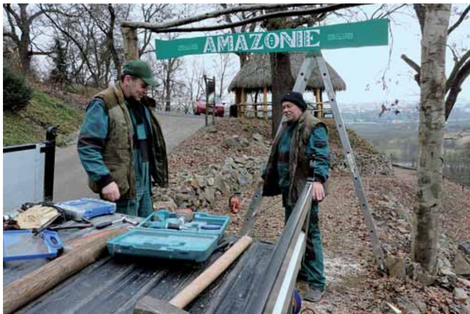
J. Škubal a J. Vonášek při dokončovacích pracích J. Škubal and J. Vonášek during finishing work
