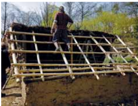
Výměna východní poloviny krovu severní polozemnice Changing of the roof frame of the northern hut
