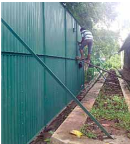
Stavba třímetrového plotu Building of a three meters high fencing
