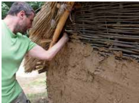
Výstavba a výmaz zadního štítu polozemnice Building and spreading of the back shield of a hut
