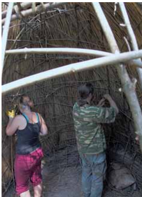
Privazování rákosové krytiny pomocí prutů a pruhů mladé kůry a lýka na konstrukci budoucího příbytku lovců a sběračů Binding of reed roof covering by twigs, bands of young bark and bast (a future construction of hunters and fruit pickers hut)
