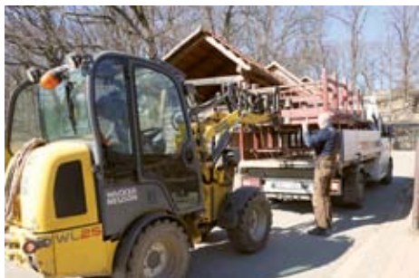
Kolový čelní nakladač při rozvozu lavic. KM Wheel loader delivering benches
