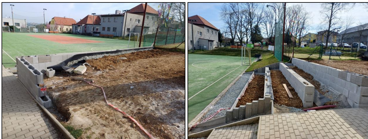
Stavba tribuny – březen – duben 2025.
