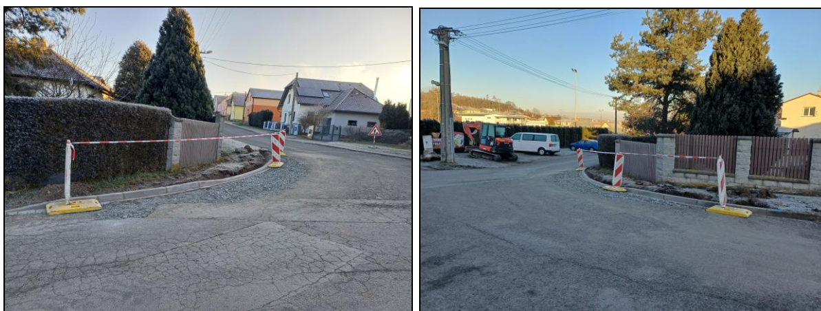
Úprava rádiusu silnice pro snadnější průjezd křížením ulic Veverí – Cihlářská. 1. únor 2025.
