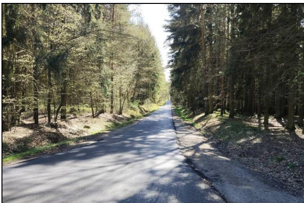
Položený asfaltový povrch.
