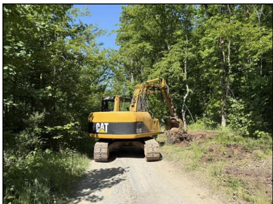
Zahájení prací v květnu.
