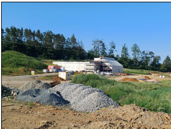
Stav staveniště 14. června 2025.
