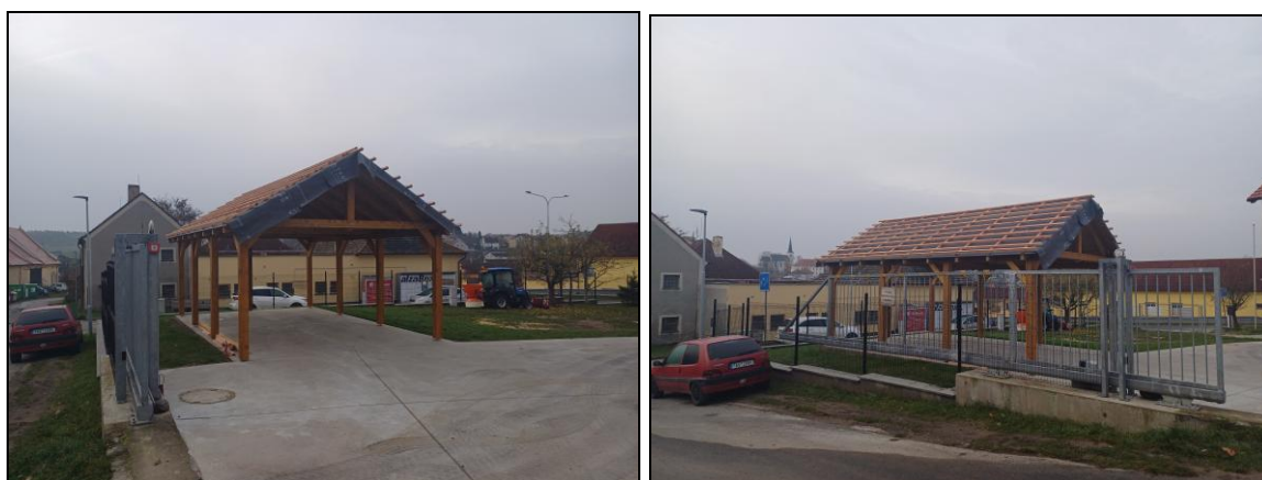
Snímky novostavby v areálu zbrojnice. Samotná plocha byla budována v říjnu 2025. Střecha byla dokončena v listopadu.
