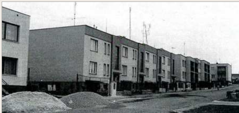
Výstavba řadových domků
