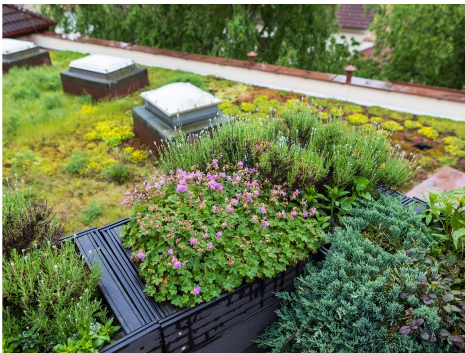
Obr. 6: Vegetační střecha na budově Tyršovy ZŠ a MŠ Plzeň (zdroj: Nadační fond Zelený poklad).
