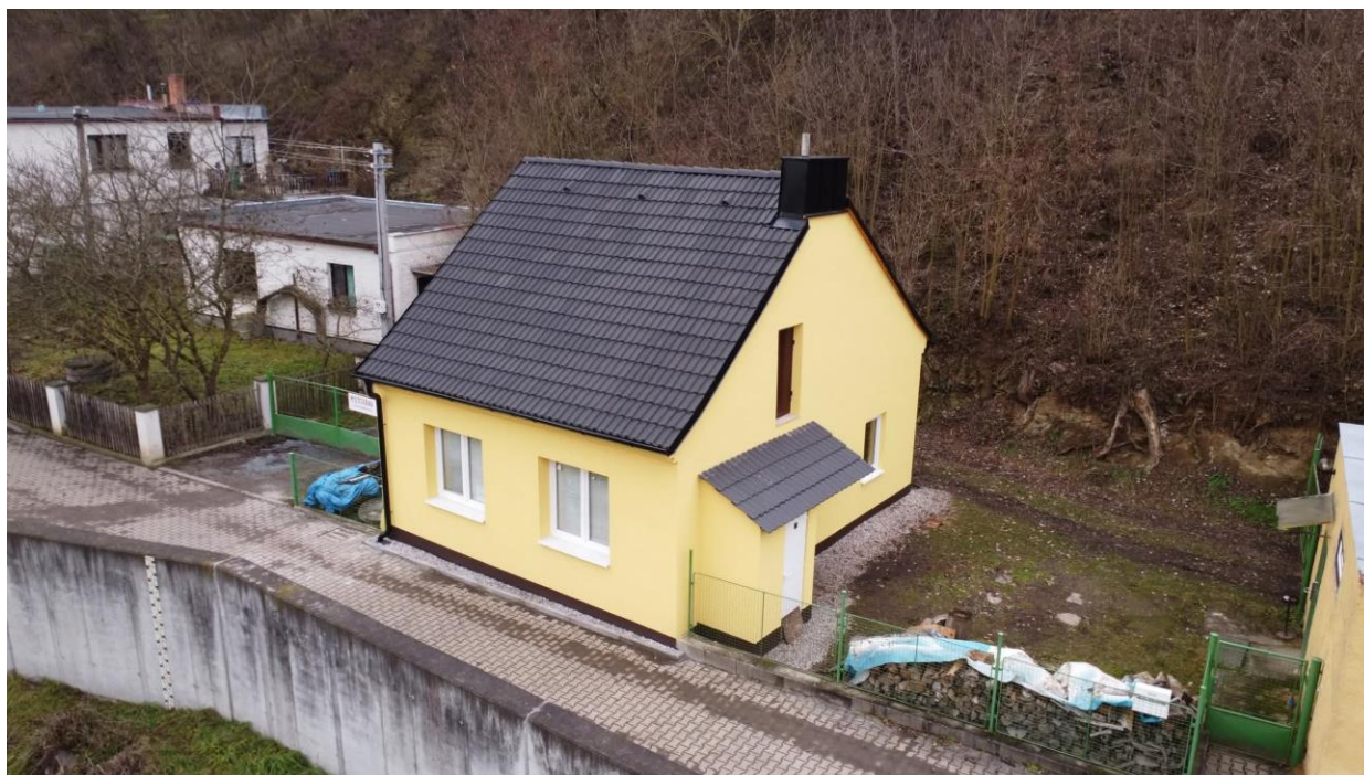
Fotografie: Pavel Polák. Budova moštárny po opravě fasády. 2025.
