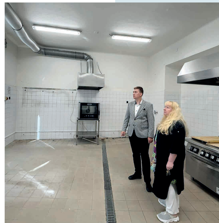
Novou vzduchotechniku s rekuperací získá kuchyně 32. MŠ.
