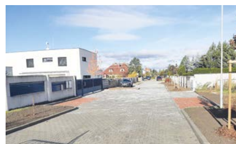
Obytná ulice Na Výsluní 2 – výstavba obytné ulice v posledním úseku ulice Na Výsluní ve směru k Olympii.
