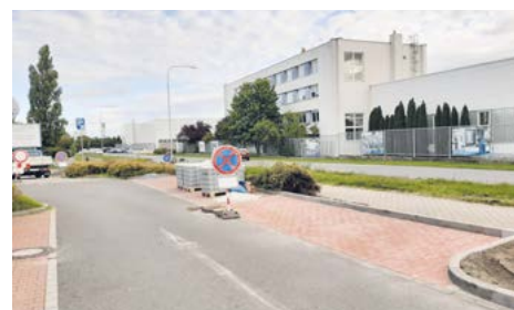
Úprava vjezdu Koterovská 160 – úprava komunikace pro snadnější výjezd hasičské techniky z nově rekonstruované zbrojnice.
