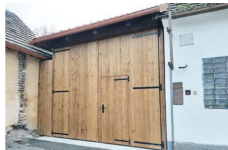
Hasičská zbrojnice Koterov – vybudování nového přístřešku včetně podkroví v areálu SDH v Koterově na Koterovské návsi.
