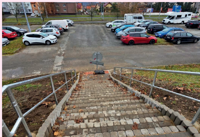
Schodiště je vybudované z betonových palisád. Foto: ÚMO Plzeň 1
