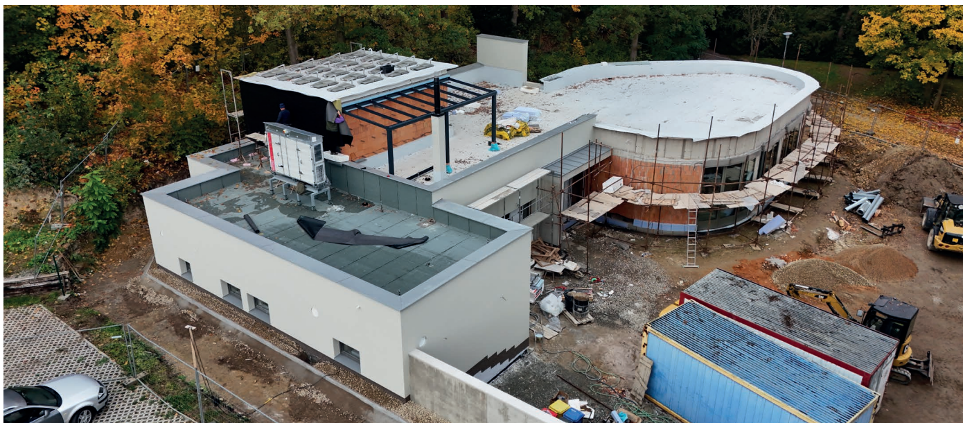
Stavba v polovině října. Foto: Jakub Šroubek
