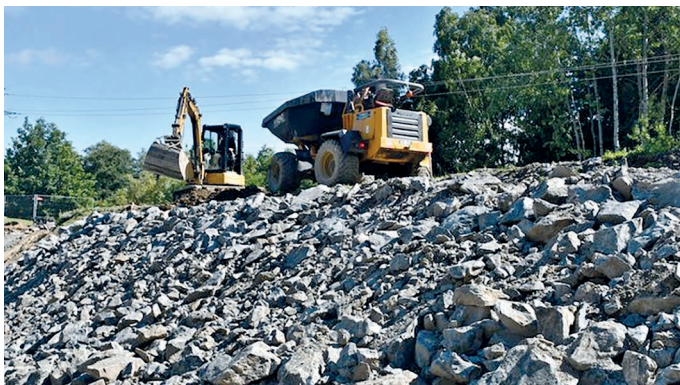
Hráz byla zatěsněna lomovým kamenem. Foto: SVS MP
