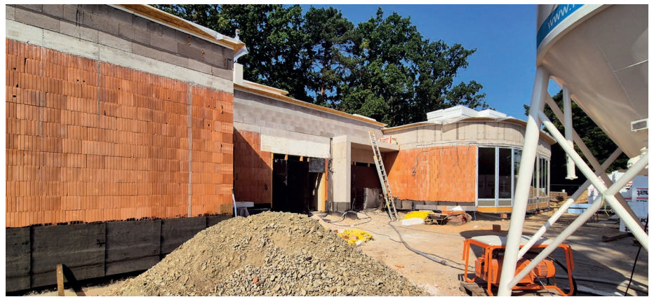
Na staveništi. Hrubá stavba je již dokončena. Foto: ÚMO Plzeň 1
