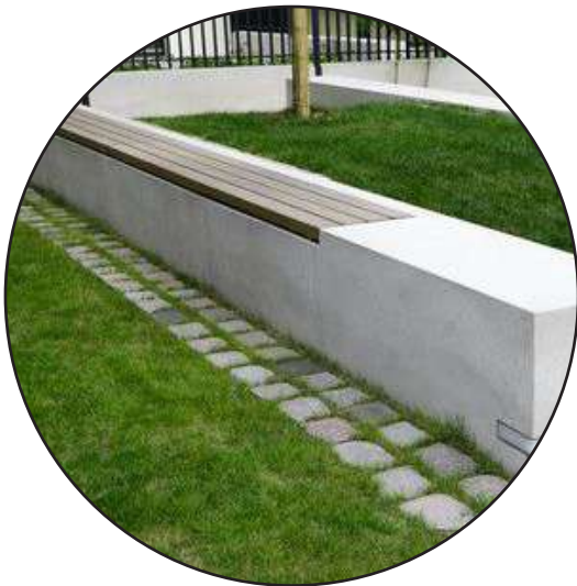
Betonové bloky na sezení
