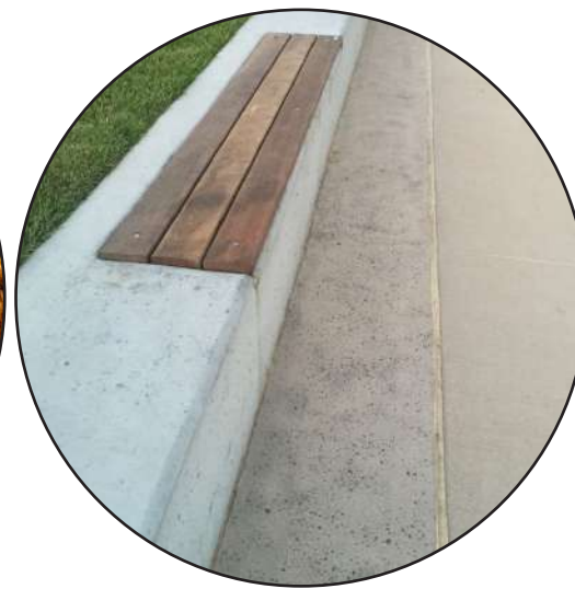
Lavice na betonové opěrcce
