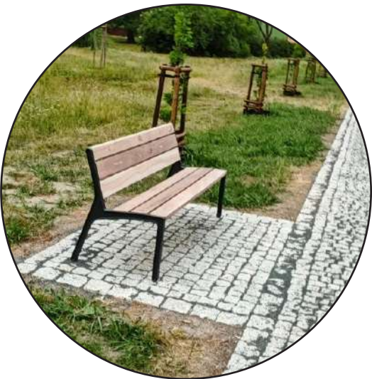
Základna pod lavičkami
