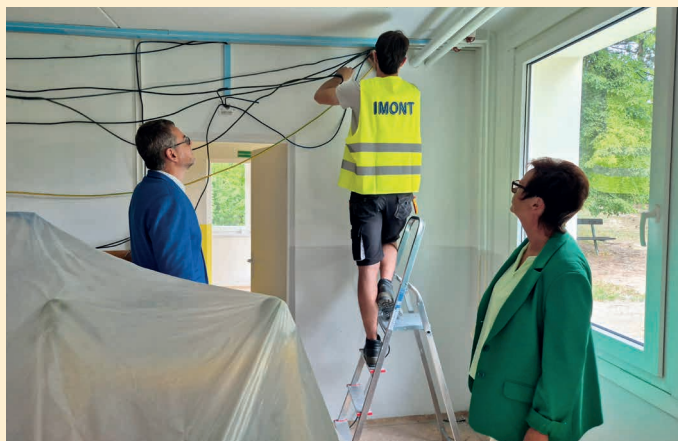
V 90. MŠ. Postup prací na výměně elektroinstalace si během léta prohlédli starostka Jedničky Ivana Bubeníčková a první místostarosta Miroslav Šuma. Foto: ÚMO Plzeň 1
