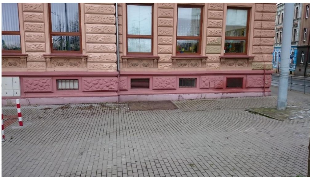
TS v suterénu 17. základní školy, Malická ulice
