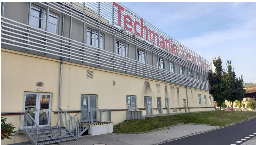
Vestavěná TS v objektu Techmanie, areál Škoda, ulice U Planetária
