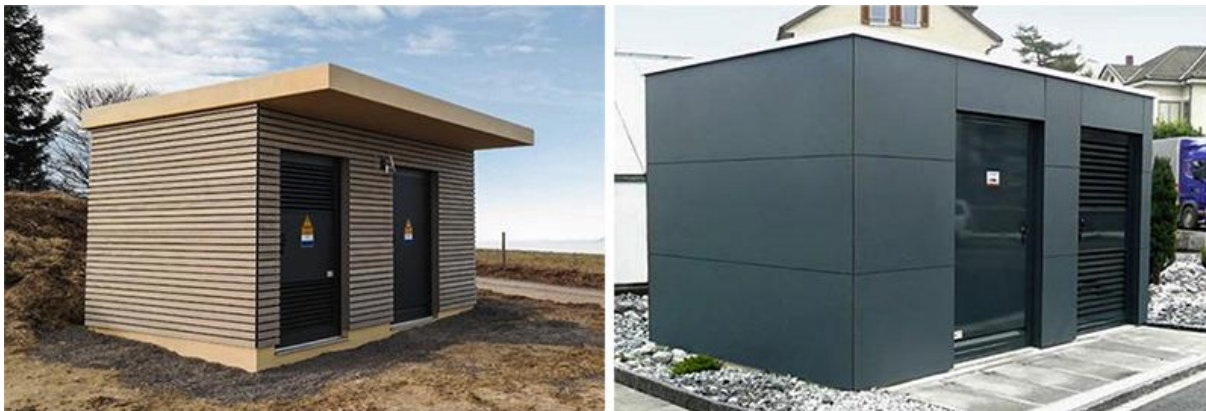
Příklad vhodného materiálového provedení volně stojící kompaktní TS Zdroj: https://www.elektroprumysl.cz/energetika/betonbau-a-energie-pro-elektromobilitu
