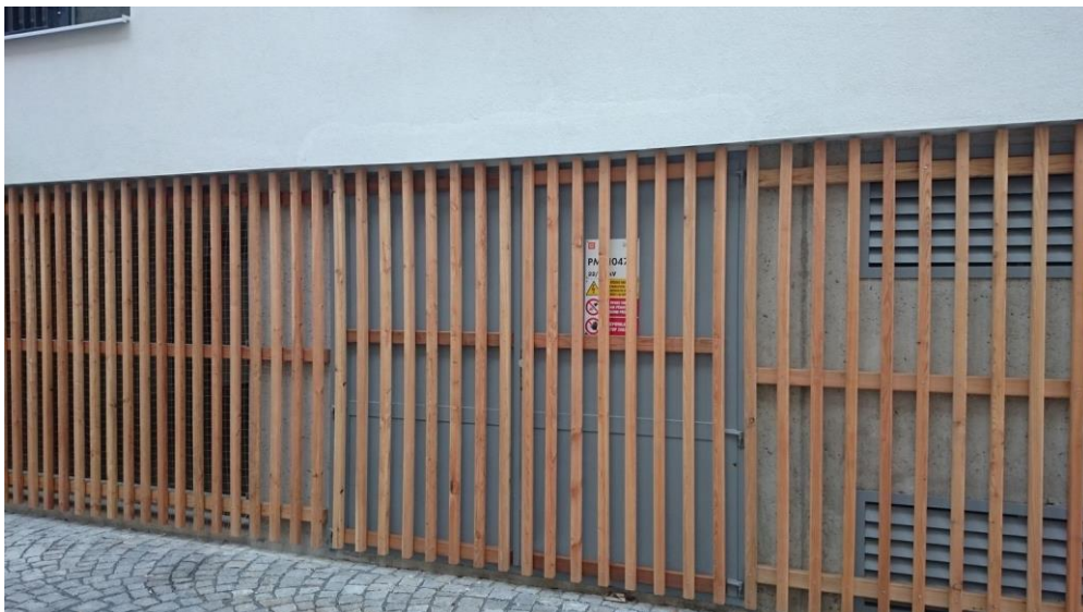
Vhodné řešení – vestavěná TS v 1. nadzemním podlaží novostavby bytového domu, Sladová ulice
