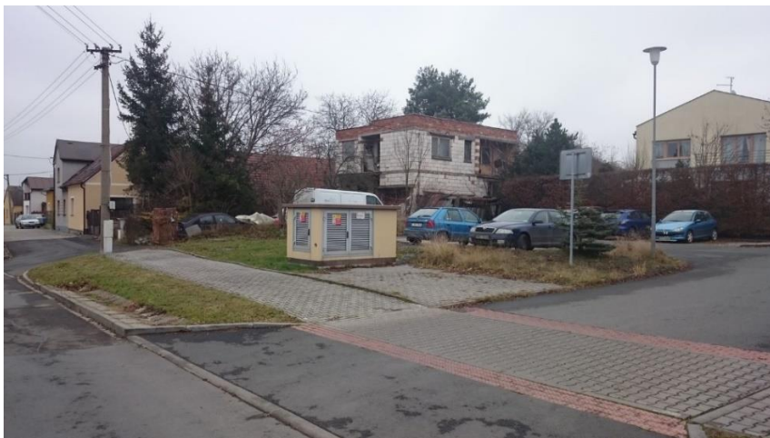
Volně stojící kiosková betonová TS, ulice Staroveská Nevhodné umístění na pohledově exponovaném místě uličního prostoru
