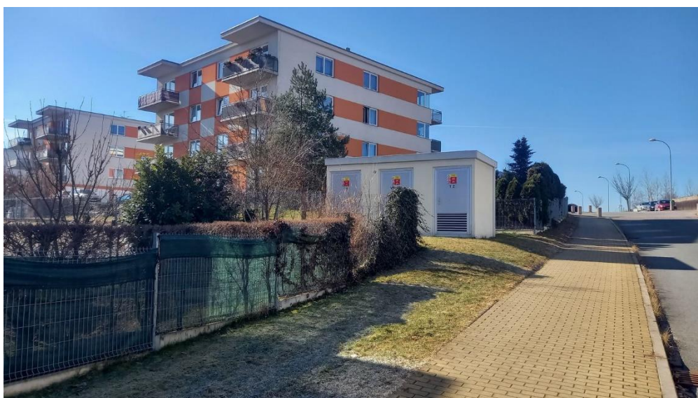
Vhodné umístění betonové kioskové TS mimo uliční prostranství v okraji bloku, Šatovská ulice
