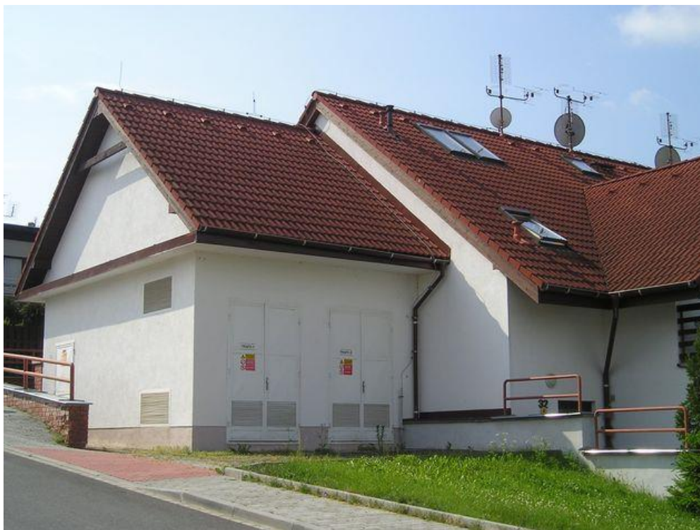
TS s vnitřní obsluhou v přístavbě, Heřmánková ulice
