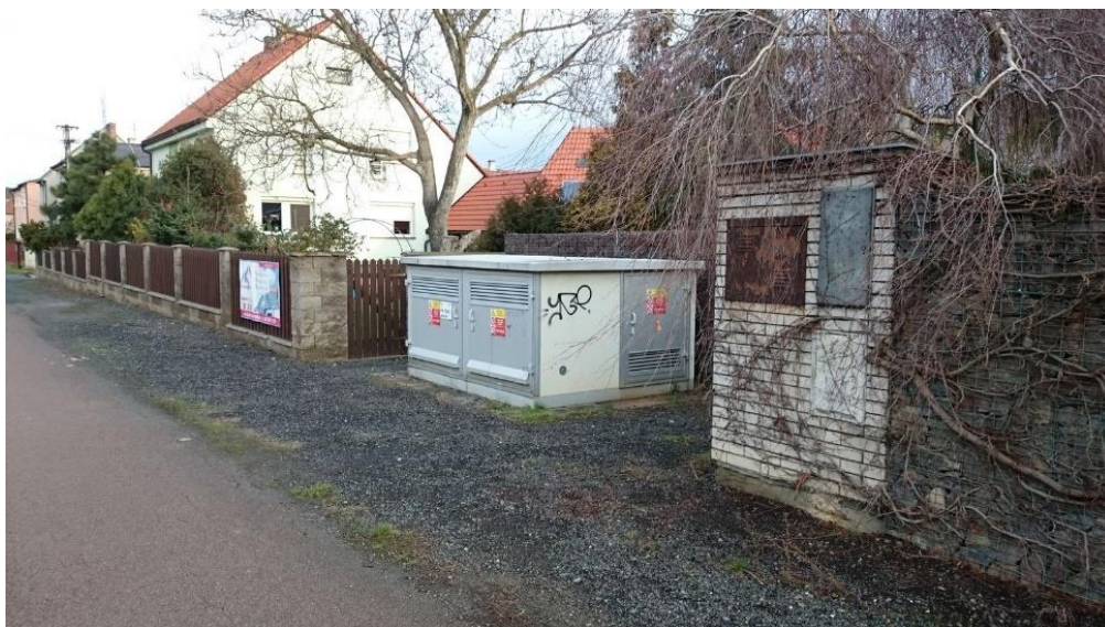
Polozapuštěná kiosková betonová TS s vnější obsluhou, Společná ulice
