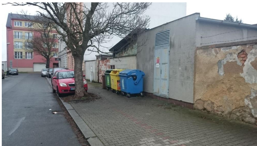
Zděná TS, Plánská ulice
