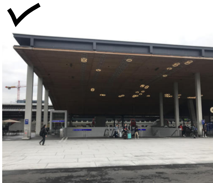
Hauptbahnhof, Curych. Všechny vstupy do prostoru hlavního nádraží přímo navazují na okolní veřejná prostranství. Mají dostatečně velkorysé parametry pro pohyb cestujících, jsou bez nadbytečných konstrukcí a objektů a vybavené jednoduchým informačním systémem.
