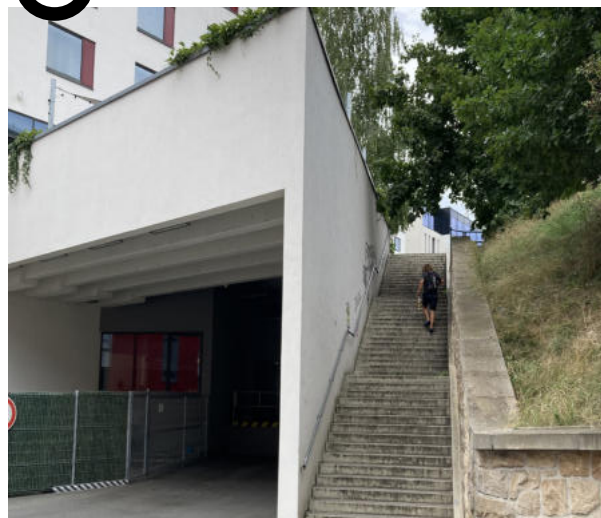
zásobovací vjezd do budovy v Nádražní ulici, Plzeň.
