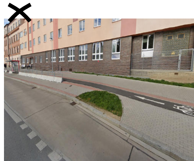
u Borského parku, Plzeň. Příklad nevhodného vedení cyklostezky za zastávkou, zde navíc spojeného s oddělením dopravním betonovým zábradlím, které do městského prostředí nepatří.
