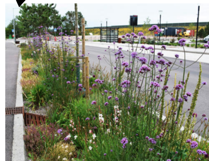
Vellinge. Modro-zelená infrastruktura - příklad spojení vegetace s objektem HDV - pás podzemní rýhy s otevřeným podkladem mezi chodníkem a vozovkou.
