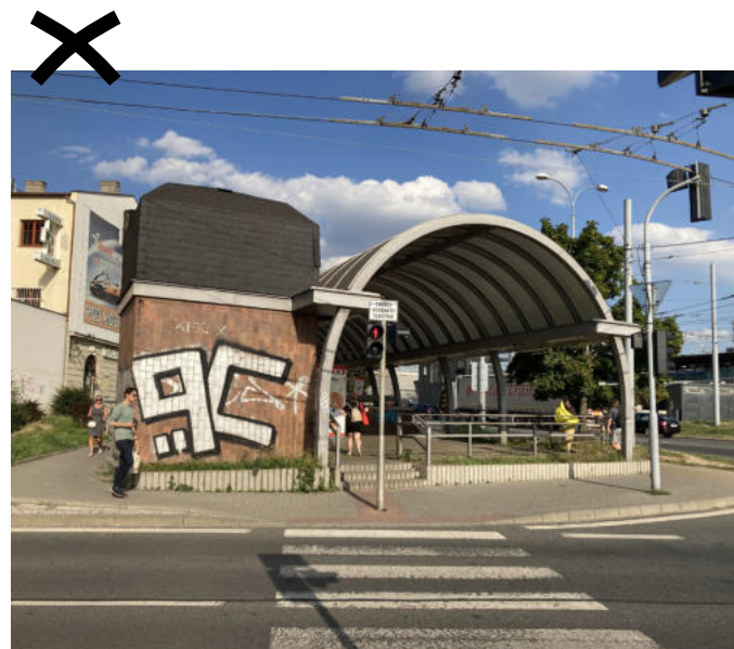
křižovatka ulic Šumavská a Ukrajinská, Plzeň. Příklad objektu technické infrastruktury (zde ještě v kombinaci se vstupem do podchodu), který se ve veřejném prostoru nevhodně uplatňuje.
