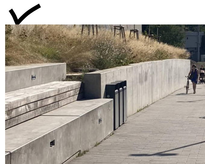
pěší trasa z hlavního nádraží na Žižkov, Praha. Vhodné umístění odpadkových košů zapadající do podoby a uspořádání místa.
