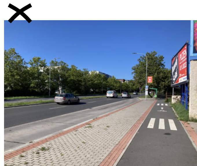
Slovany, Plzeň. Vedení cyklopruhu za pěším koridorem směrem od vozovky vytváří konfliktní situace a zvyšuje nároky na dopravní značení snižující plynulost provozu – zde je vidět řešení přístupů k objektům veřejné vybavenosti pomocí pěších přechodů.
