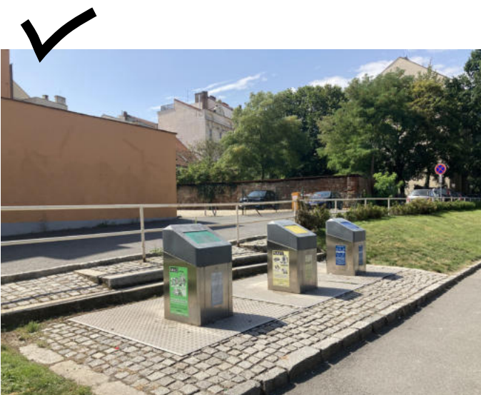
Plzeň. Příklad kultivovaně provedeného okolí podzemních nádob na odpad.
