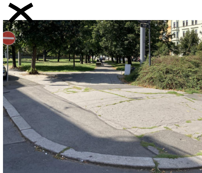
Husovo náměstí, Plzeň. Náměstí má kvalitní urbanistický rámec a řadu příjemných momentů včetně vzrostlé zeleně. Škodí mu zanedbaný detail a odříznutí jeho středu od parteru přilehlých budov.
