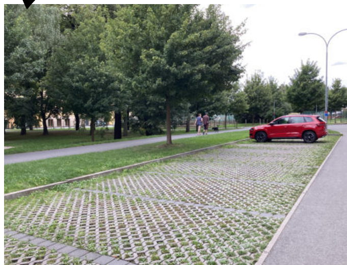
parkoviště ve Štruncových sadech, Plzeň. Ukázka začlenění prvků HDV do prostředí parkoviště.
