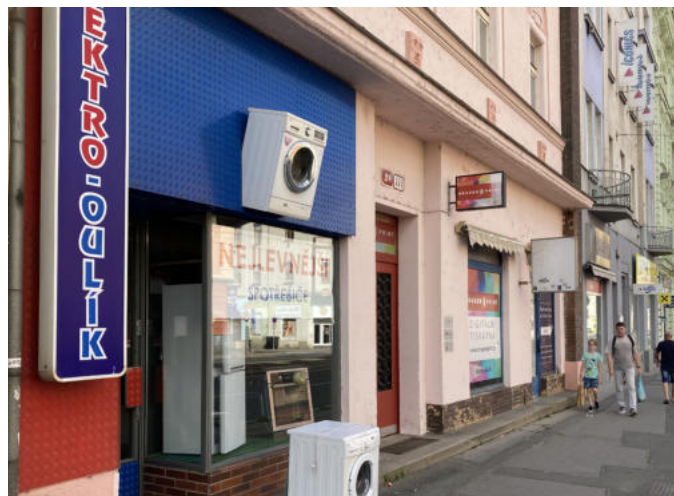
označení provozovny, Plzeň. Příklad nevhodného označení provozovny, které nerespektuje architekturu fasády a přebíjí ji zbytečným množstvím prvků.
