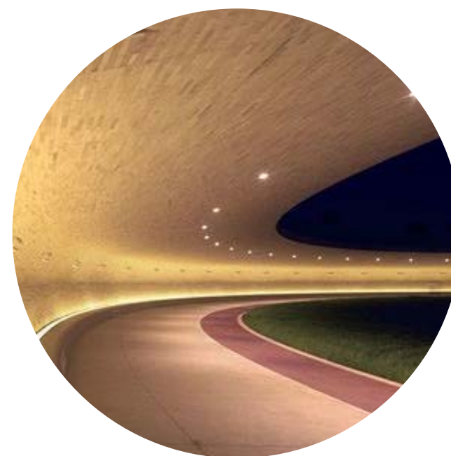
Reference: osvětlení v podmostním prostoru
