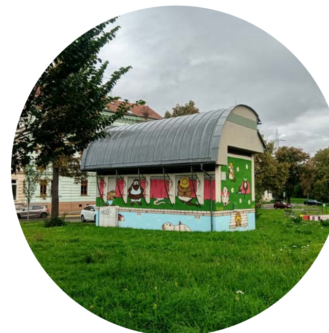
Stávající podoba objektu z jihozápadní strany
