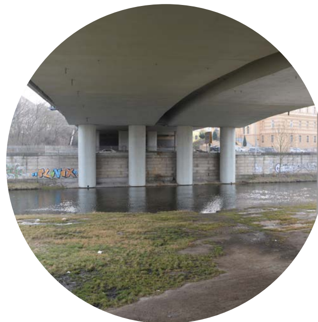
Stávající stav oblasti
