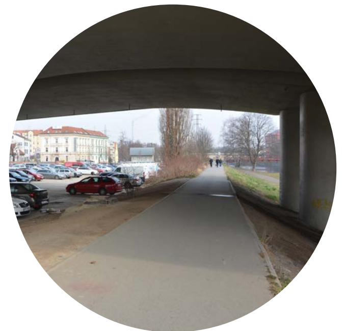
Stávající stav oblasti
