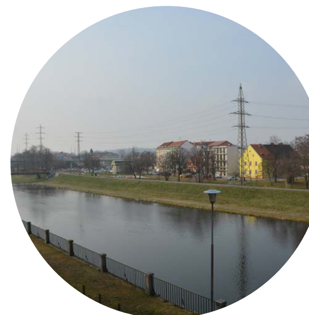
Stávající stav oblasti
