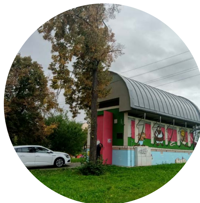
Stávající podoba objektu ze severozápadní strany
