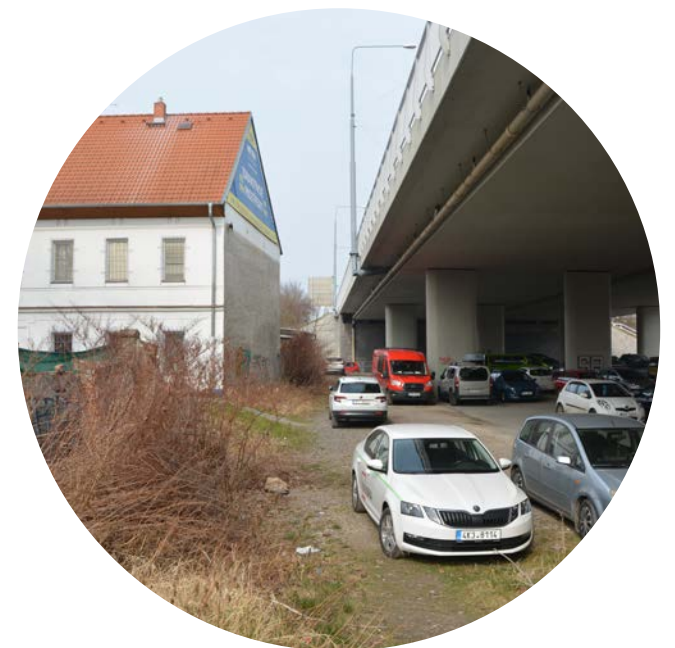
Stávající stav oblasti
