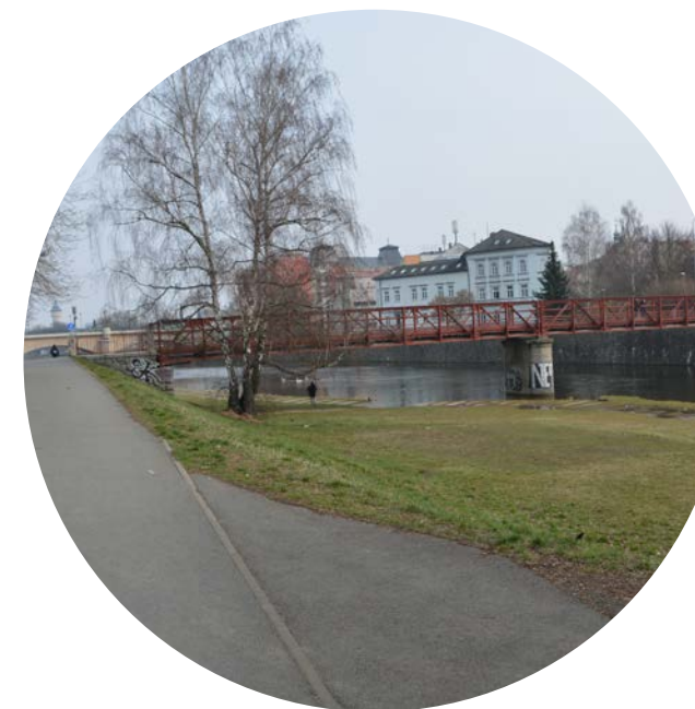
Stávající stav oblasti
