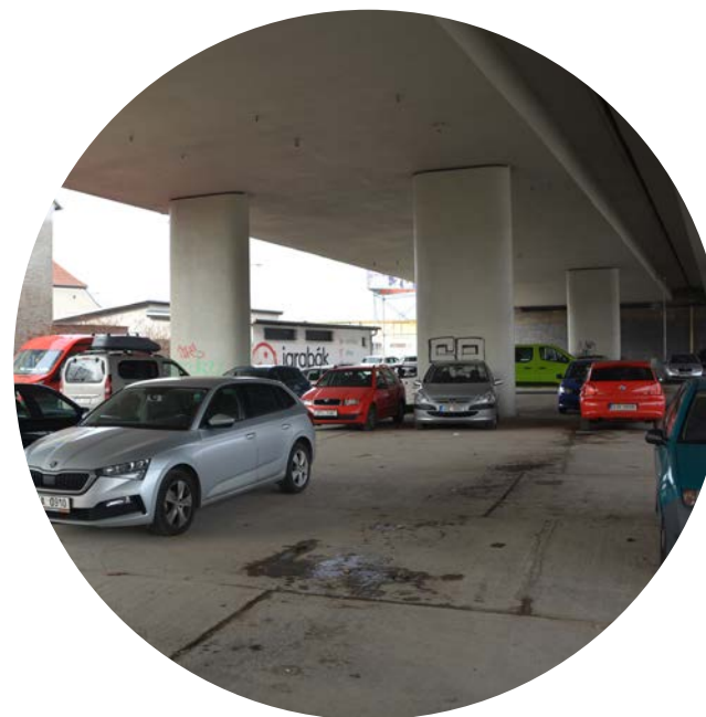
Stávající stav oblasti
