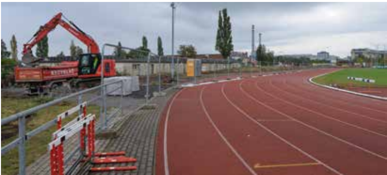
Na Atletickém stadionu města Plzně začala výstavba východní tribuny. Foto: Martin Pecuch
