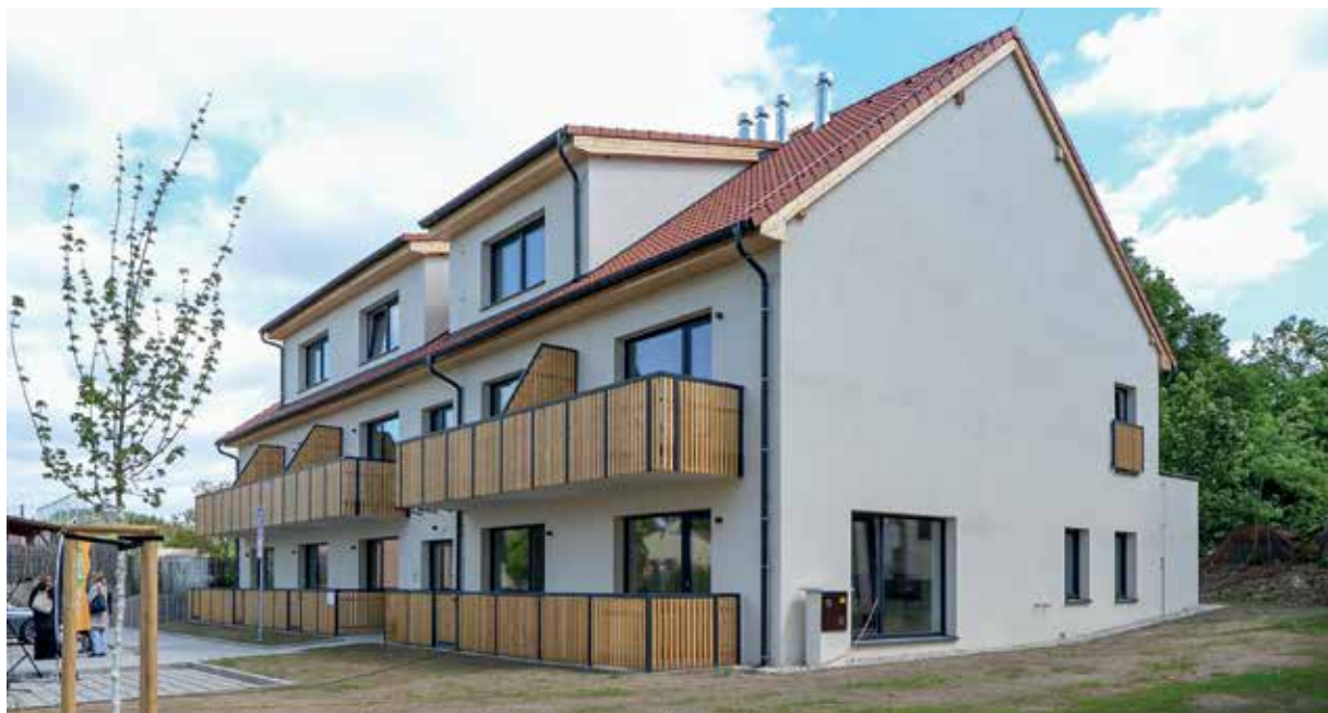
V Malesicích byl dokončen Nový Šuferajn s 12 byty, v nichž nový domov najdou lidé v bytové nouzi.
