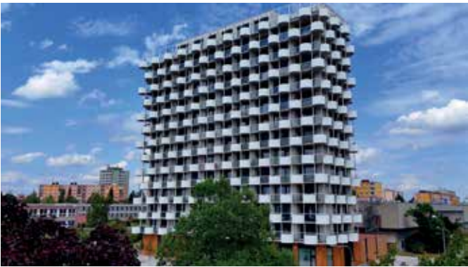
Druhé Čestné uznání poroty bylo uděleno bytovému domu U Borského parku za nápadité ztvárnění, které dům přirozeně začleňuje do stávajícího uspořádání sídliště. Nepřehlédnutelné je funkčně-estetické začlenění zeleně do výrazové struktury fasády a hravá barevnost v interiéru společných prostor.
