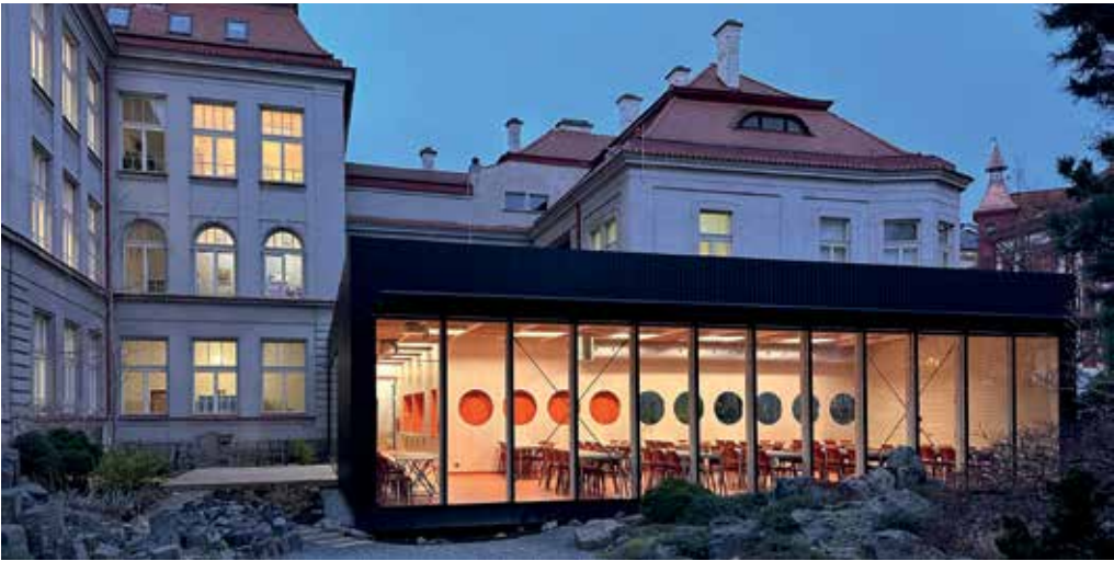
Přístavba jídelny k budově Mikulášského gymnázia získala Cenu poroty. Ta ocenila optické prolnutí vnitřní jídelny s prostorem navazující zahrady. Vzdušná moderní dřevostavba příjemně kontrastuje s historickou budovou gymnázia.
