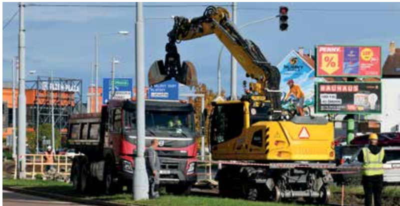
Tramvajová trať spojující centrum města se čtvrtí Skvrňany byla v nevyhovujícím stavu. V říjnu začala její rozsáhlá rekonstrukce.
