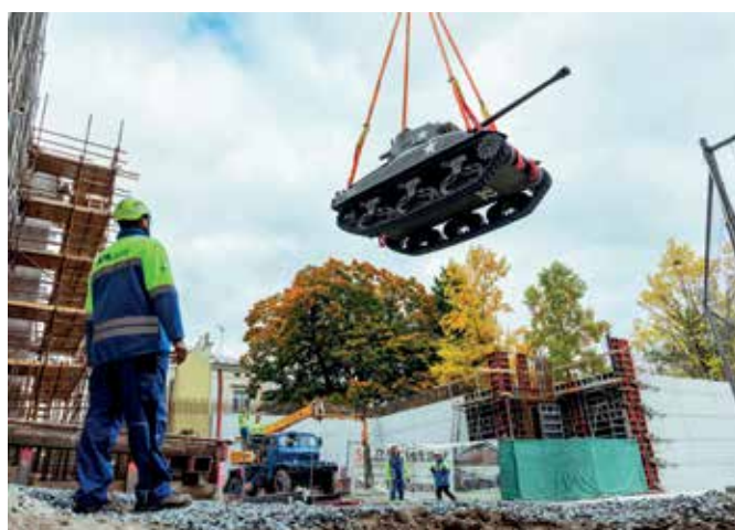
Třicetitunový tank byl po přehoupnutí přes střechu domu usazen ve speciální přístavbě na dvoře Klatovské 19.
