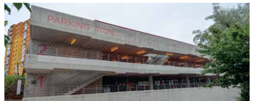
Vícepodlažní parkoviště Atom v Sokolovské ulici má 173 míst. Foto: Martin Pecuch
