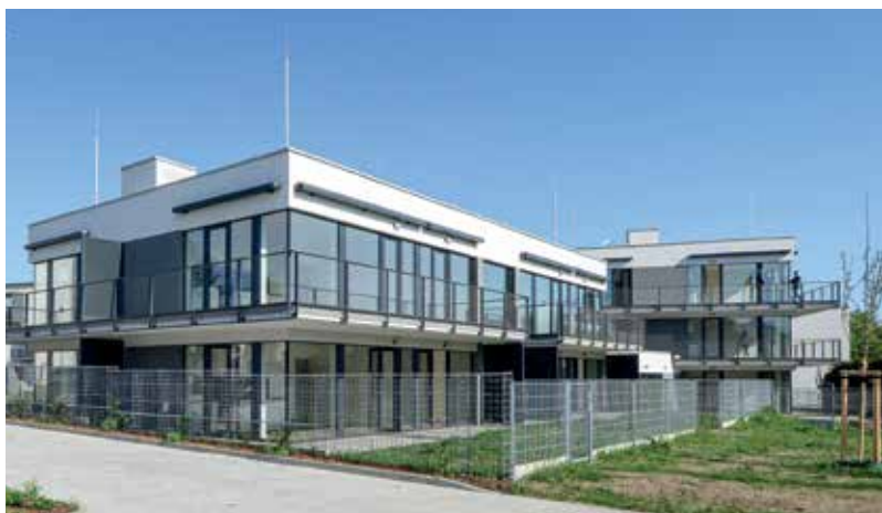
V Kreuzmannově ulici postavilo město Plzeň nový dům se sedmnácti nájemními byty. Foto: Martin Pecuch
