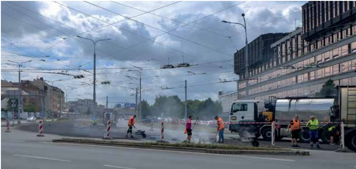
Během července byla opravena za 25 milionů korun tramvajová trať v křižovatce U Jána.
