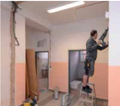
Ve 13. ZŠ vzniká přístavba s novými učebnami. Foto: Martin Pecuch
