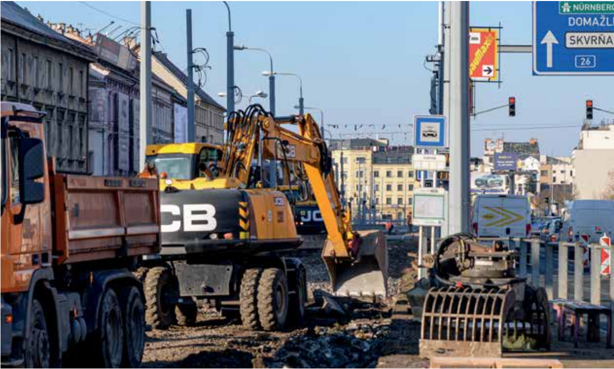
V lednu začala druhá etapa rozsáhlé rekonstrukce tramvajové trati do Skvrňan.
