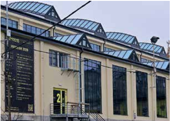
Opravená střecha, fasáda, vyměněná okna s pětistovkou originálních tabulí skla a nové světlíky na jedné z budov. To vše zahrnovala první etapa rozsáhlé rekonstrukce kulturní a kreativní zóny DEPO2015. Modernizaci prošla tzv. trolejbusová hala, v níž se nacházejí výstavní prostory, kreativní dílny a kavárna. Za technicky náročné stavební práce trvající rok zaplatilo město Plzeň 77 milionů korun bez DPH. V navazující etapě, která potrvá do srpna 2026, se v téže budově zrenovují interiéry. Foto: Miroslav Chaloupka
