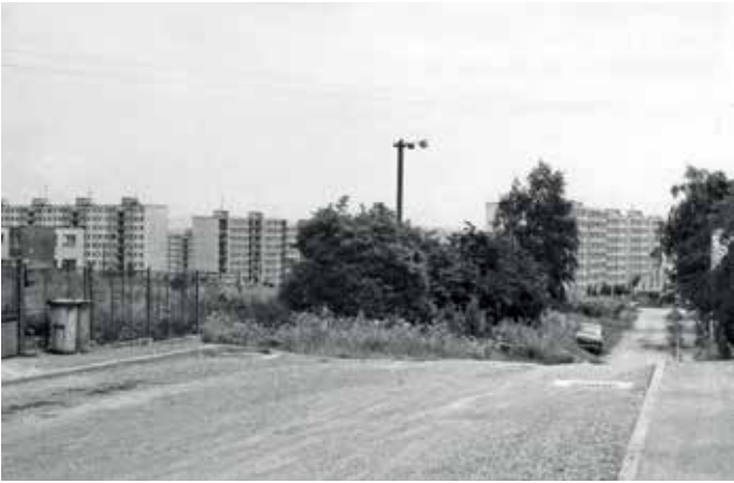
Snímek z roku 1987 nabízí pohled na sídliště Košutka z ulice K. Pečím. Foto: Tomáš Jochec. Zdroj: Archiv města Plzně
