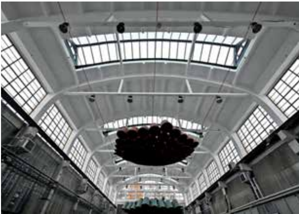
Opravená střecha, fasáda, vyměněná okna s pětistovkou originálních tabulí skla a nové světlíky na jedné z budov. To vše zahrnovala první etapa rozsáhlé rekonstrukce kulturní a kreativní zóny DEPO2015. Modernizaci prošla tzv. trolejbusová hala, v níž se nacházejí výstavní prostory, kreativní dílny a kavárna. Za technicky náročné stavební práce trvající rok zaplatilo město Plzeň 77 milionů korun bez DPH. V navazující etapě, která potrvá do srpna 2026, se v téže budově zrenovují interiéry. Foto: Miroslav Chaloupka
