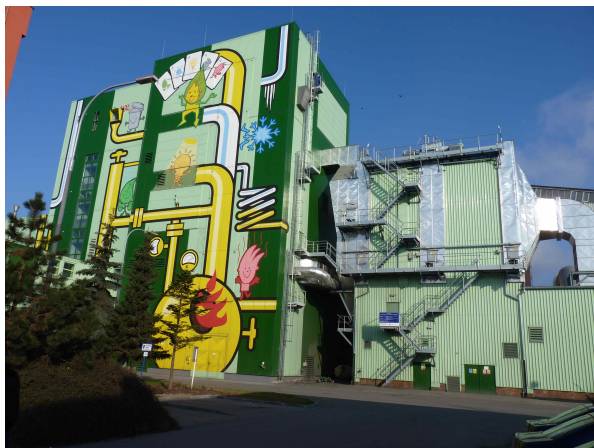
↑ Zelený energoblok (Plzeňská teplárenská a.s.) – výroba elektřiny a tepla z biomasy
