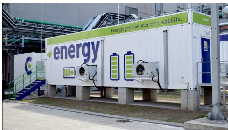
Bateriové úložiště v areálu energetického zdroje C-Energy Planá
