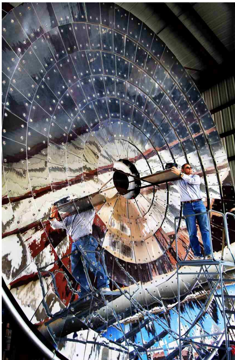
Montáž slunečního kolektoru, jež bude poskytovat sluneční energii pro chod CR5. Kredit: Randy Montoya
