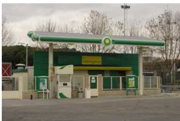
Vodíková čerpací stanice - Barcelona
