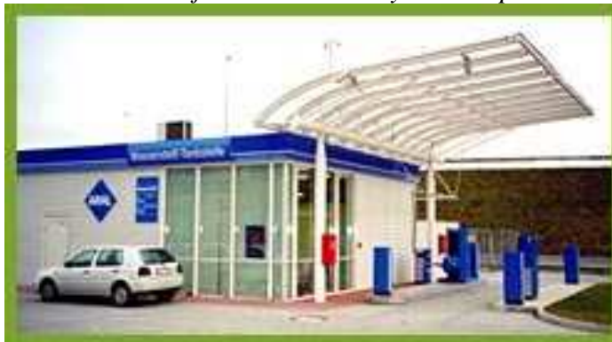
Vodíková plnicí stanice
