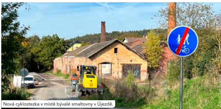
Podél komunikace ještě bude vysazena ovocná alej.
