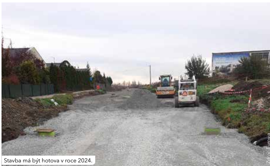
Současné práce na rekonstrukci Červenohrádecké.
