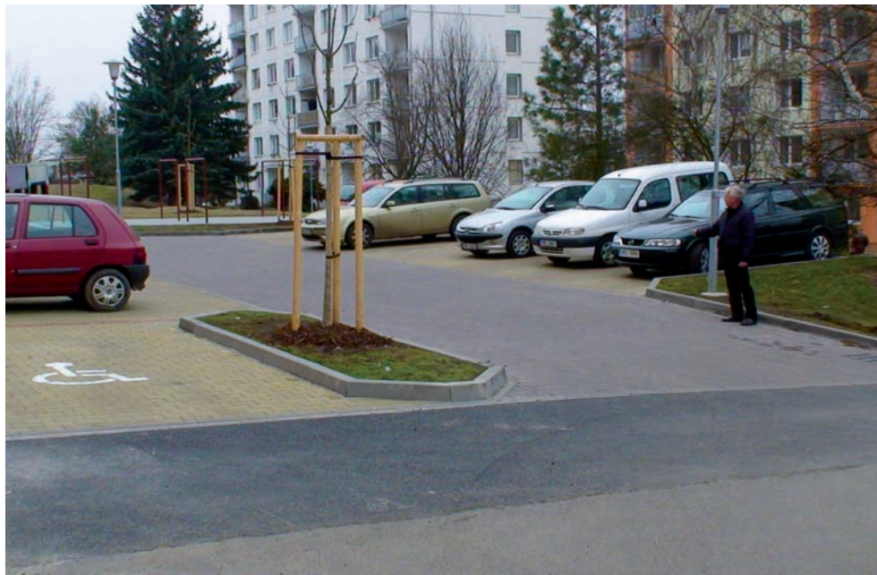
Parkoviště v Popelnicevě ulici slouží lidem, ukazuje Evžen Krommer, vedoucí odboru majetku a investic ÚMO P4. V ceně jejich výstavby nejsou jen samotná parkovací místa, ale i příjezdové cesty, úprava povrchu v okolí, zeleň a třeba i přesunutí sušáků na prádlo.
