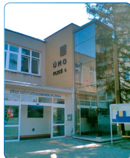
Nový vstup do budovy
