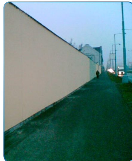
Po prořezu spár a po nátěru
