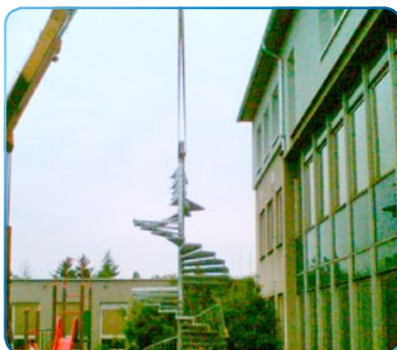
Montáž požárního schodiště
