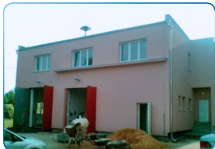
Rekonstrukce před dokončením...
