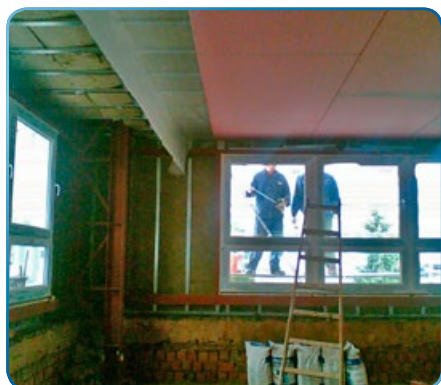
Při provádění nástavby
