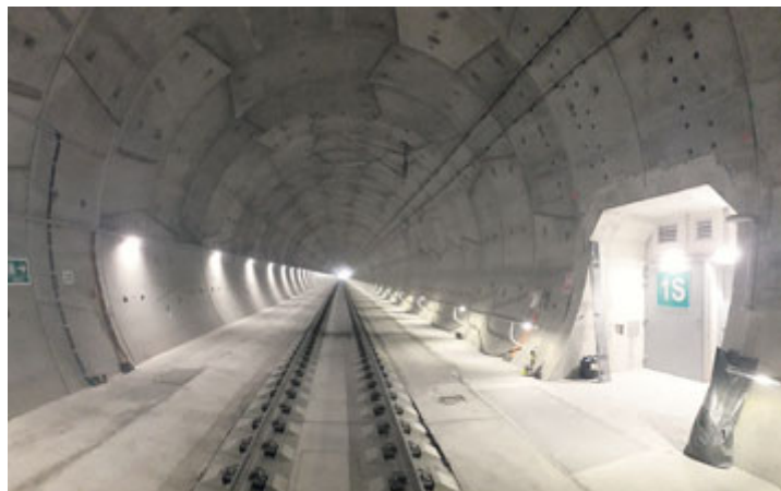
Severní tunel se vstupem do propojky č. 1
