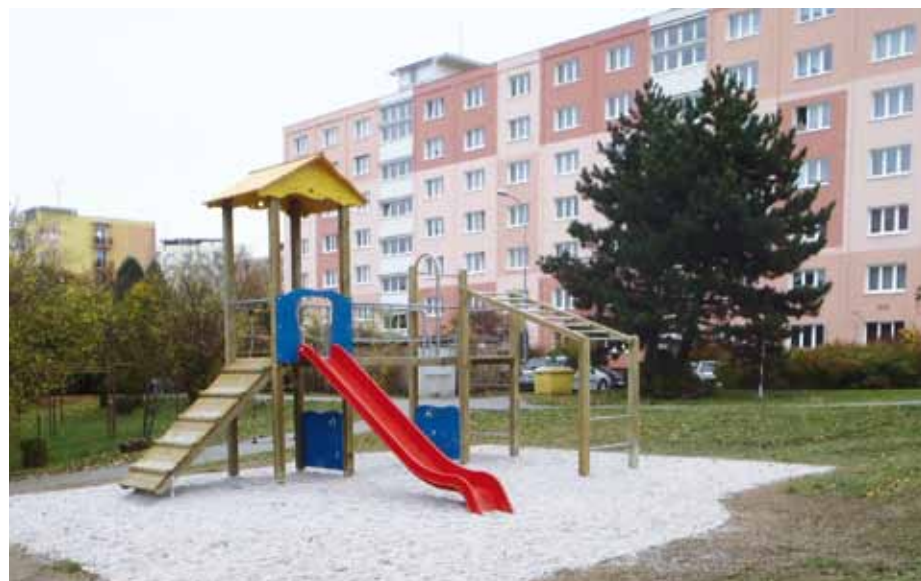
Před několika týdny byla v zeleni mezi Rokycanskou ulicí a domem Partyzánská 46 dokončena stavba nového dětského hřiště. Do této lokality byla umístěna nová herní sestava Santa Ponsa a lanová dráha Montana. Dětské hřiště bude ještě rozšířeno o další drobné dětské prvky a mobiliář. Na žádost občanů bylo zároveň v rámci této akce rozšířeno dětské hřiště ve vnitrobloku Ke Kukačce 3 o duo houpačku Orel.
