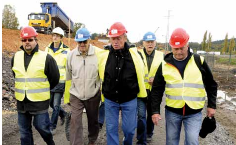
Stavba nového mostu na Jateční ulici v Plzni-Doubravce se na jeden den mimořádně zpřístupnila veřejnosti. Stavbaři připravili Den otevřených dveří pro školy a veřejnost. Stavbu si prohlédl i starosta MO4 Michal Chalupný.
