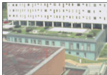
Střecha pavilonu onkologie. Dvojice snímků pořízených tzv. termovizní kamerou: horní snímek ukazuje rozdíly v teplotě snímaného povrchu. V popředí je dobře vidět asfaltová střecha rozpálená až na 70 stupňů Celsia (červená plocha). Uprostřed obrázku je zelená střecha účinně chlazená vegetací. Je to řešení nejen hezké, ale je přínosné i pro pacienty a nemocniční personál za okny nad střechou.
