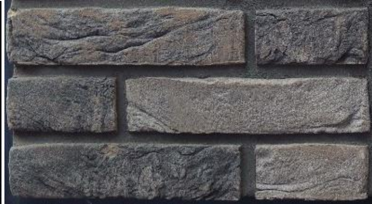
Metselwerk – Baksteen – Cortona
