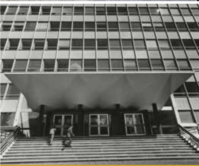
◀ De karakteristieke betonnen entreeuilif van het voormalige Shellkantoor en Lummusgebouw. The characteristic flat concrete canopy of the former Shell offices.
