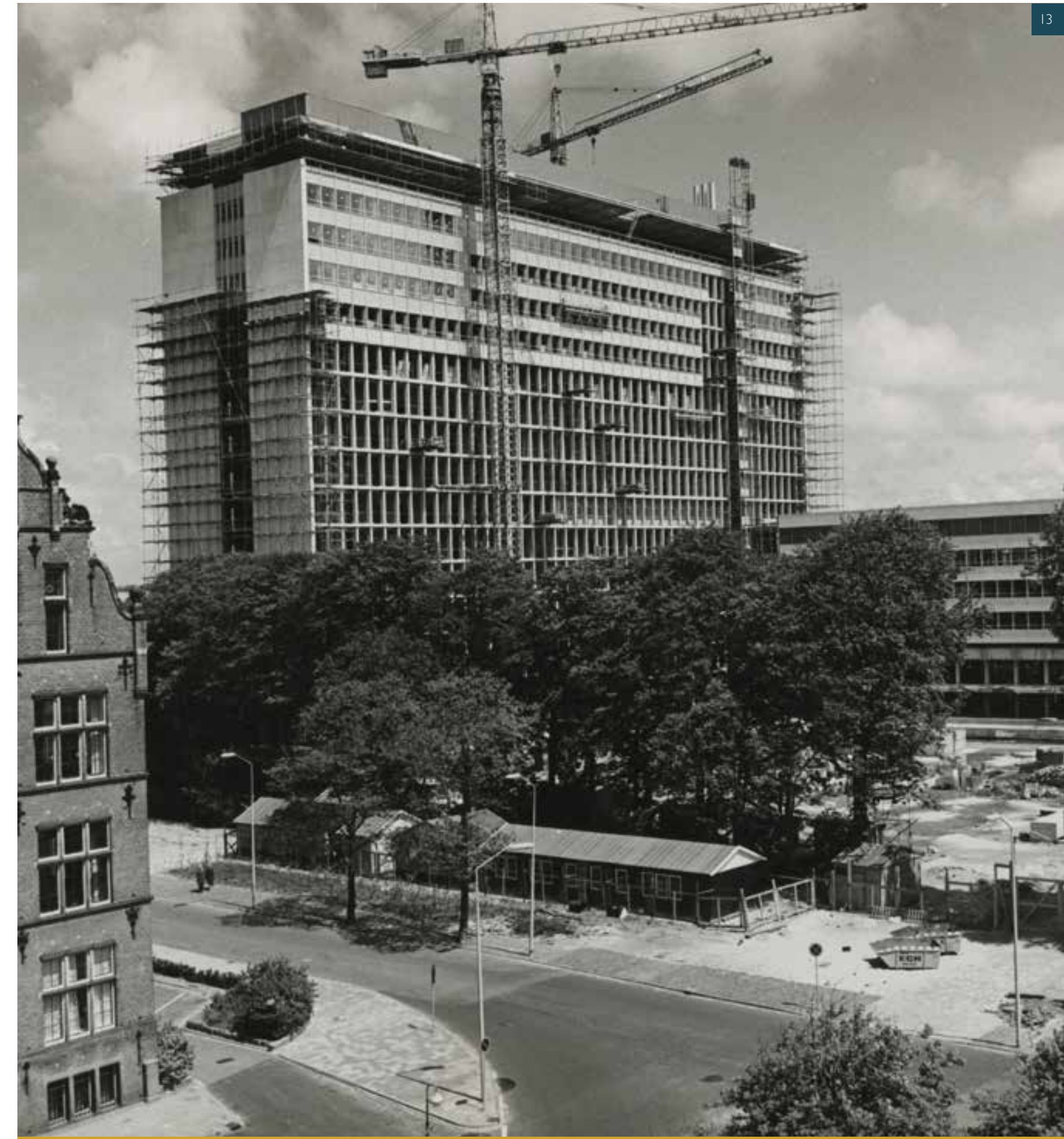
▲ Het Shellkantoor in aanbouw, 1968. Construction of the Shell offices, 1968.
